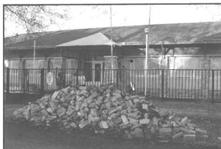
Újjászületőben a Rákóczi utcai óvoda
