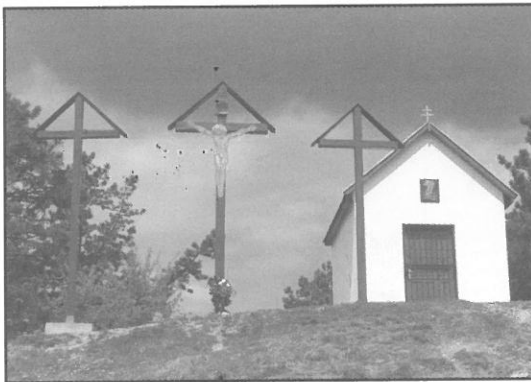
A húsvéti ünnepekre helyreállították a vandálok által megrongált Kálváriát
