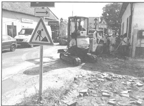
A Postánál már befejezték a csövek fektetését
