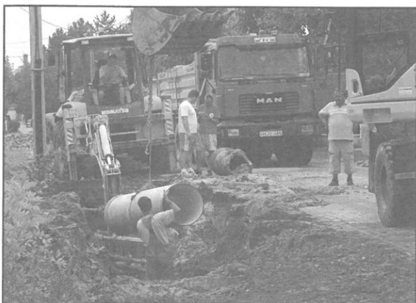
Csapadékvíz-elvezető csatorna építése a Béke utcában
