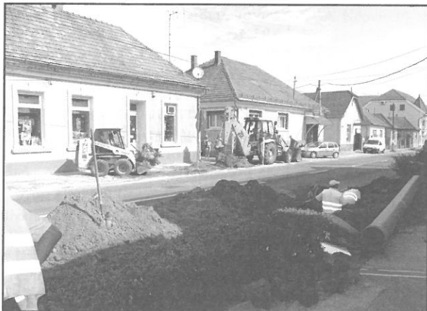
A Magyar Aszfalt munkásai a csapadékvíz-elvezető csatorna csöveit helyezik el a Fő utcán
