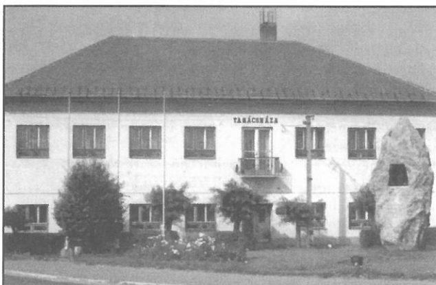
1974-ben átépítették a tetőt és a homlokzatot. A praktikum jócskán az esztétika rovására ment...
