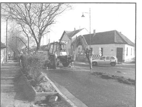
Finisébe érkezett a jelzőlámpás kereszteződés építése: a munkagép megkezdte a terelősziget kialakítását
