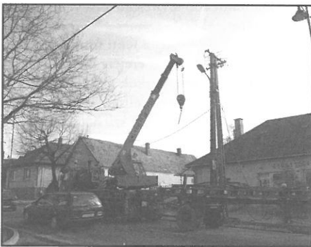
Nagy odafigyelést és ügyességet követelő balesetveszélyes munkamozzanat: a kiszolgált villanyoszlopok kiemelése
